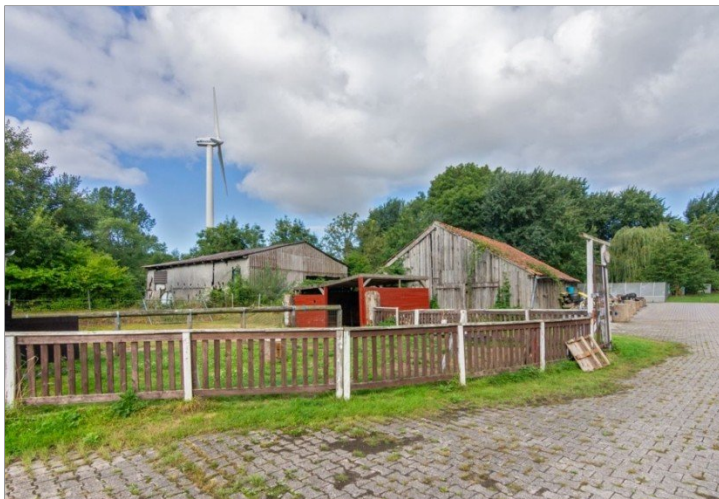
7996 Nebengebäude Bild II
