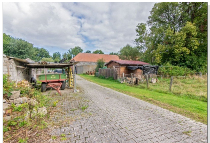
7996 Zuwegungen und Nebengebäude Bild II
