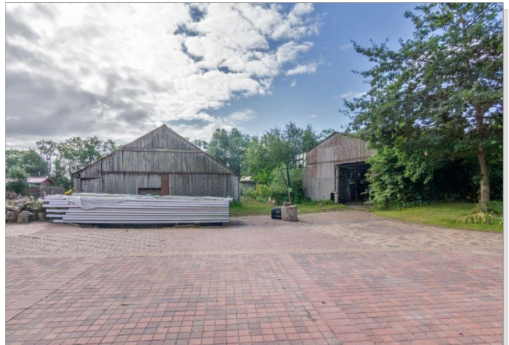
7996 Nebengebäude Bild I
