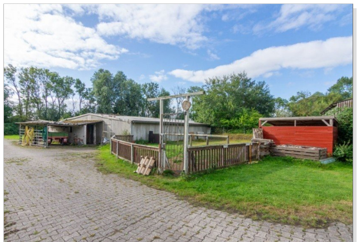
7996 ehem. Schweinestall Bild I
