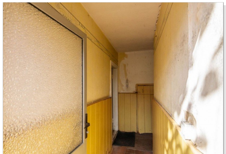
70000 Eingangsbereich und Flur
